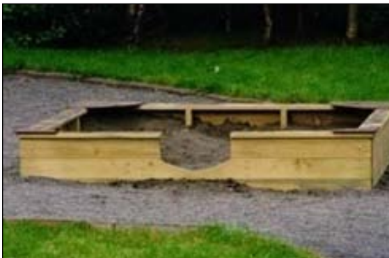
Inngangur í sandkassa góður - Horn og efri brúnir ekki hvassar
