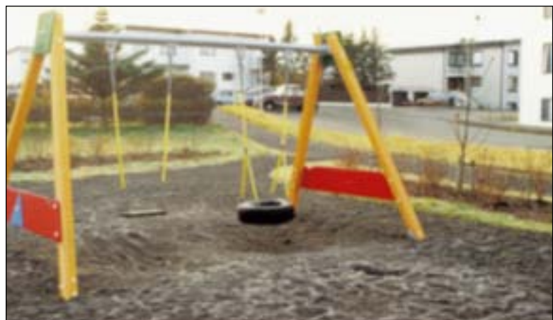
Hér má sjá hvernig undirlag hefur sparkast frá undir rólu
